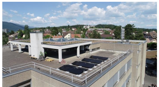
Geschafft! Das Solarlabor in fertigem Zustand
