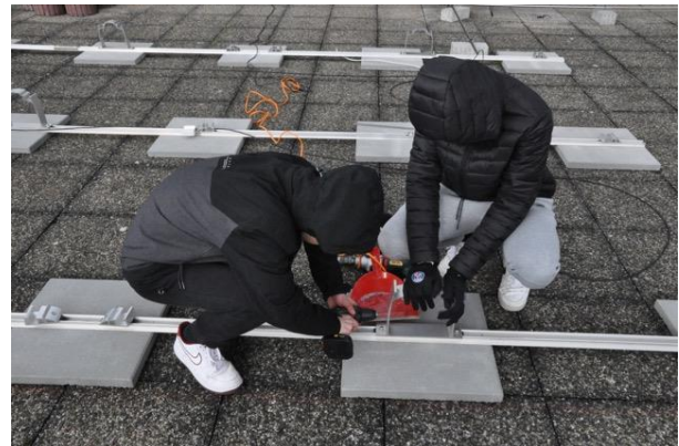
Montage der Trägerkonstruktion
